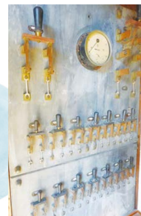
創建当初の配電盤。当時は停電が多かったが二葉御殿には自家発電装置が設置され、周辺が停電でも煌々と明かりが灯っていたという。「電力王」桃介の面目躍如
